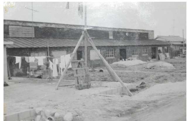
工場跡④を南西から撮影した古写真
