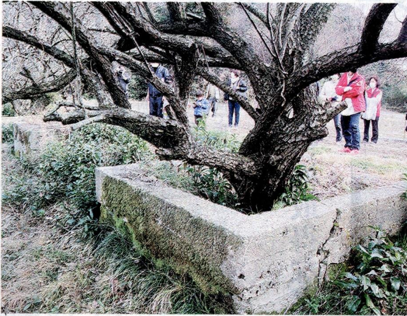
梅林の中に整然と並ぶコンクリート製の銃座＝鈴鹿市石薬師町で
