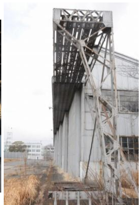
扉用のレール。扉が10枚なのでレールは5本。 2011. 2.12. 第3格納庫
