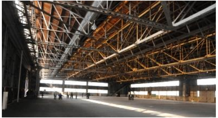
第3格納庫の内部。 2011. 2.12.
