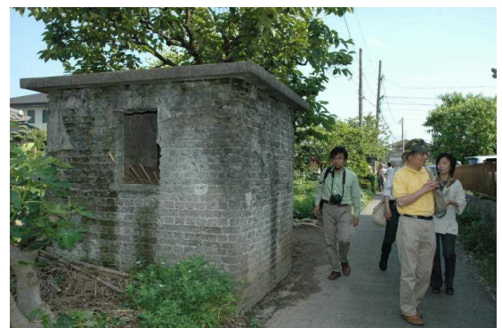
(鈴鹿海軍工廠火工部弾薬庫跡)
