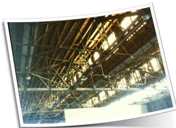
第3格納庫内部
