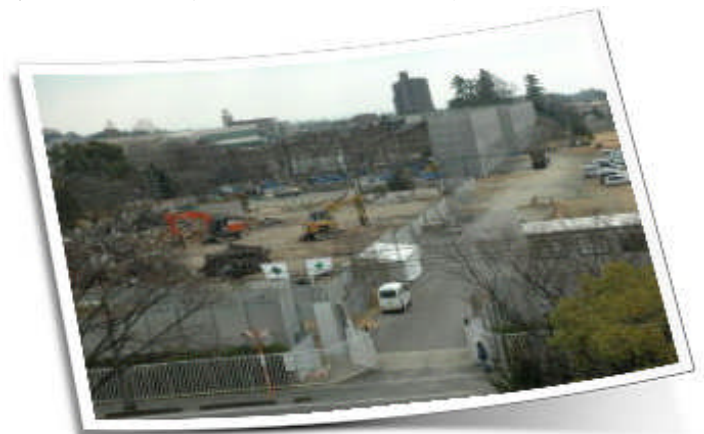
解体中の第3～5格納庫
