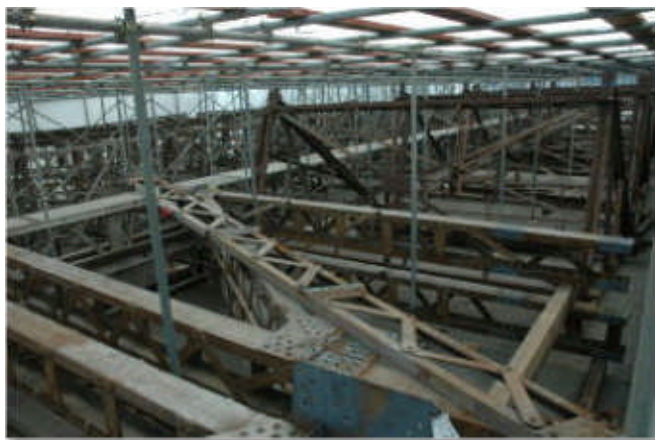
保管されている第4格納庫の部材
