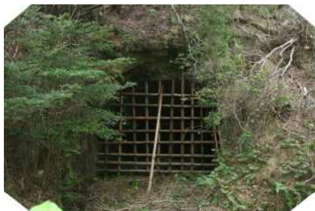
鈴鹿海軍工廠関地下工場跡
