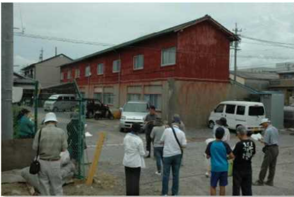
【鈴鹿海軍工廠火管庄墳工場跡】
