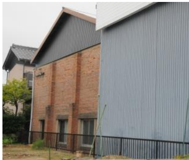
倉庫 A の外観
