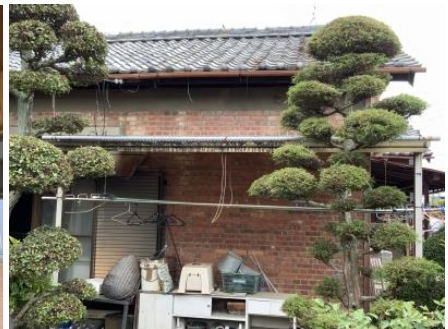
倉庫 B の外観
