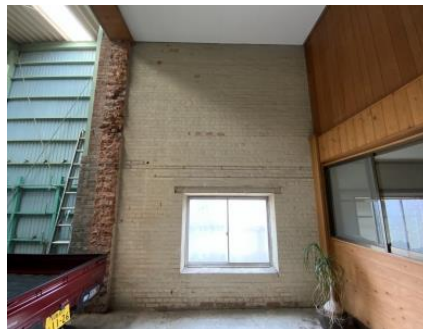
倉庫 A の内部
