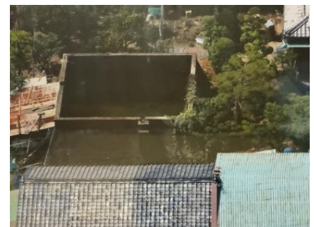
消滅したコンクリート水槽
